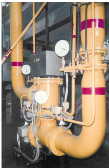
Рис. 2. Запорный клапан блока газооборудования БГ-5
