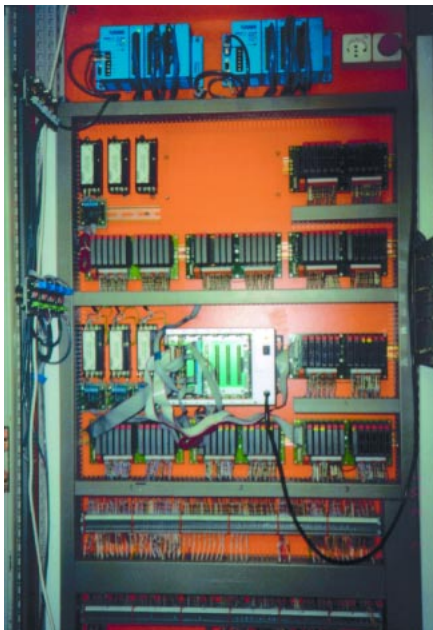
Рис. 4. Шкаф контроллеров
