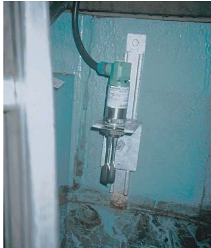
Использование датчика серии Vibracon в качестве сигнализатора предельного уровня жидкости
