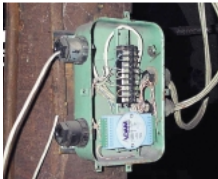
Рис. 2. Распределительное устройство с модулем ADAM-4017
