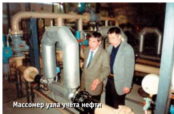
Блок измерительных линий узла учёта нефти: фильтры, струевыпрямители, расходомеры
